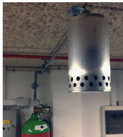
Ljuddämpare monterad på munstycke
